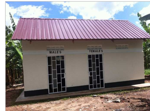
Bild: Bau des neuen Toilettenhauses 11/2015
